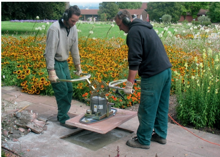
Vakuumhebergeräte können die Belastung der Wirbelsäule wirksam reduzieren
