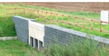
Dauerhaft vorhandene Geländer oberhalb eines Gabionenbauwerks
