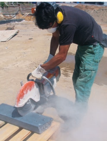
Staubbelastung beim Trockenschneiden
