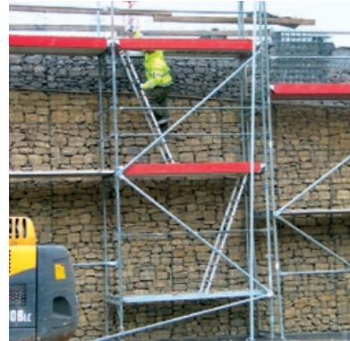
Dreiteiliger Seitenschutz in Arbeitsfeldern des Gerüstes! Sicherer Aufstieg mittels Leitengang bis 5 m Höhe.
