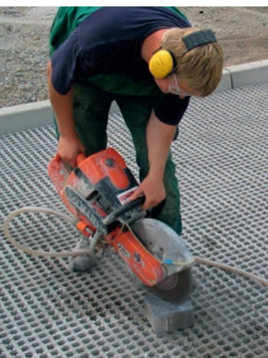
Motortrennschleifer mit Wasseranschluss reduziert die Staubbelastung
