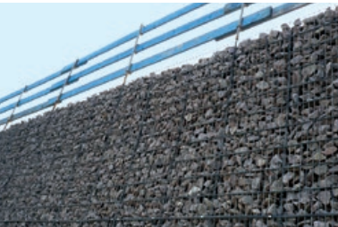
Dreiteiliger Seitenschutz auf Gabionenbauwerk bei Absturzhöhe > 2 m
