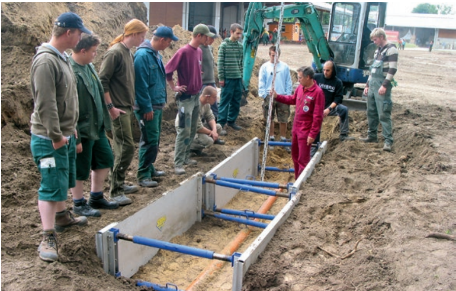
Praktische Ausbildung zum Grabenverbau (Leichtverbau)
