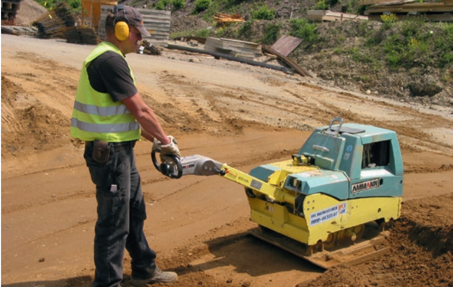
Sicheres Arbeiten mit der Rüttelplatte
