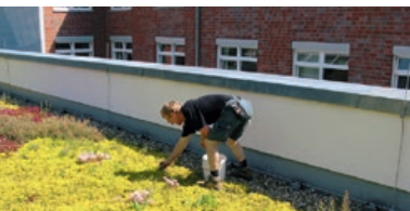
Mauer als ortsfeste Absturzsicherung
