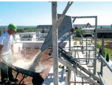
Dreiteiliger Seitenschutz auf Gabionenbauwerk bei Absturzhöhe > 2 m
